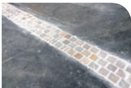
Une des traversées
