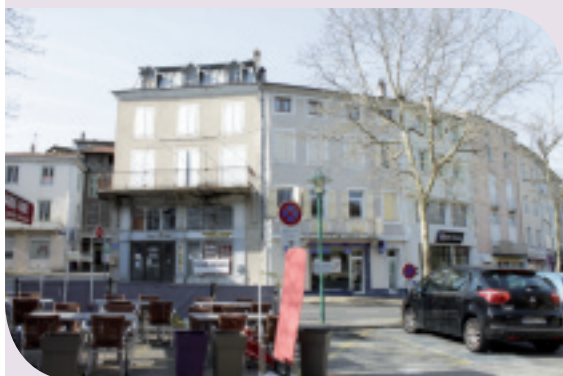
Avant démolition (depuis la place Seignobos)
