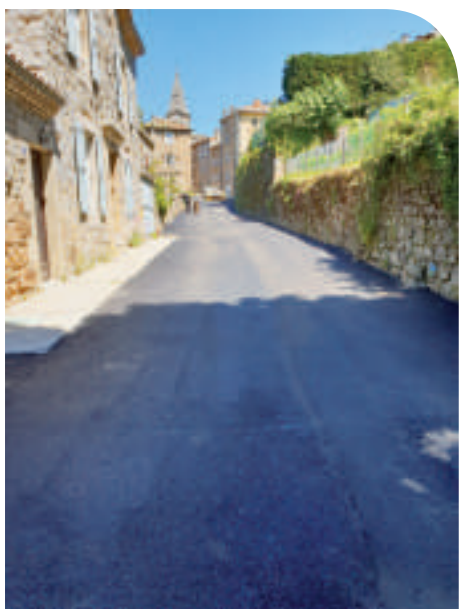
Enrobé rue Jules Ferry
