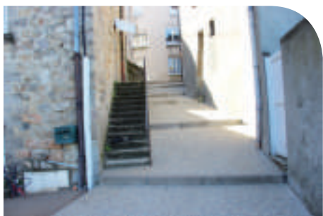
Escaliers reliant les deux rues
