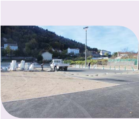
Mise en place
