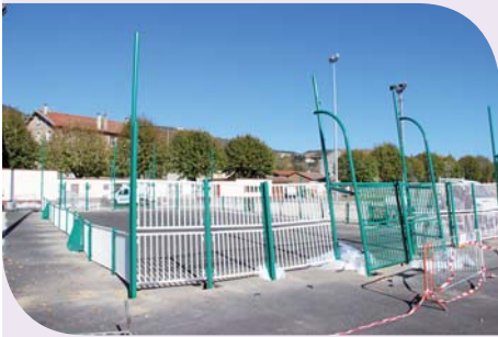
Lors de la construction
