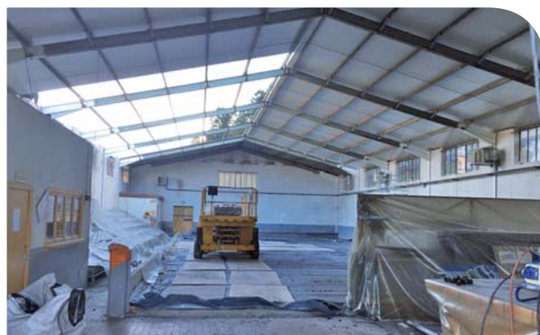
Remplacement de la toiture
